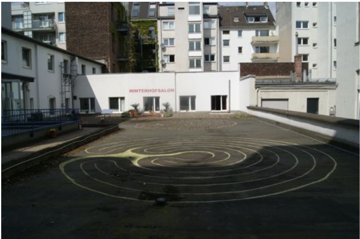
Die zwei Labyrinthformen auf dem Flachdach laden zum Begehen ein.
